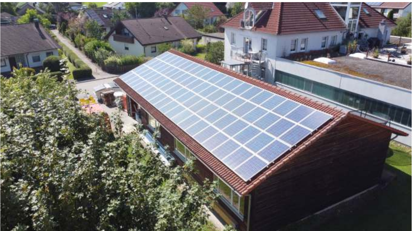
Ansicht Halle Baujahr 2000, PV-Anlage
