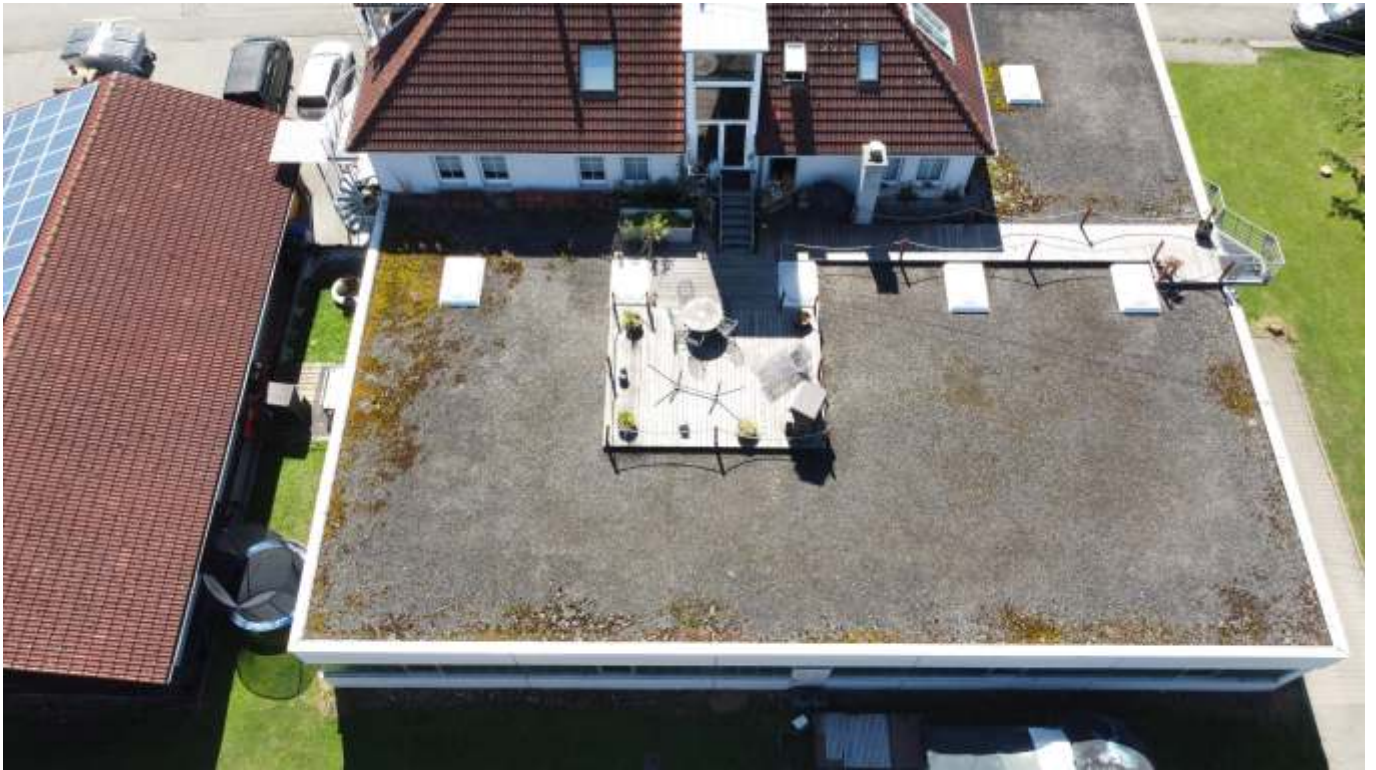
Ansicht Halle Baujahr 1975, zweite Zufahrt, Dachterrasse Dachgeschoss Hauptgebäude
