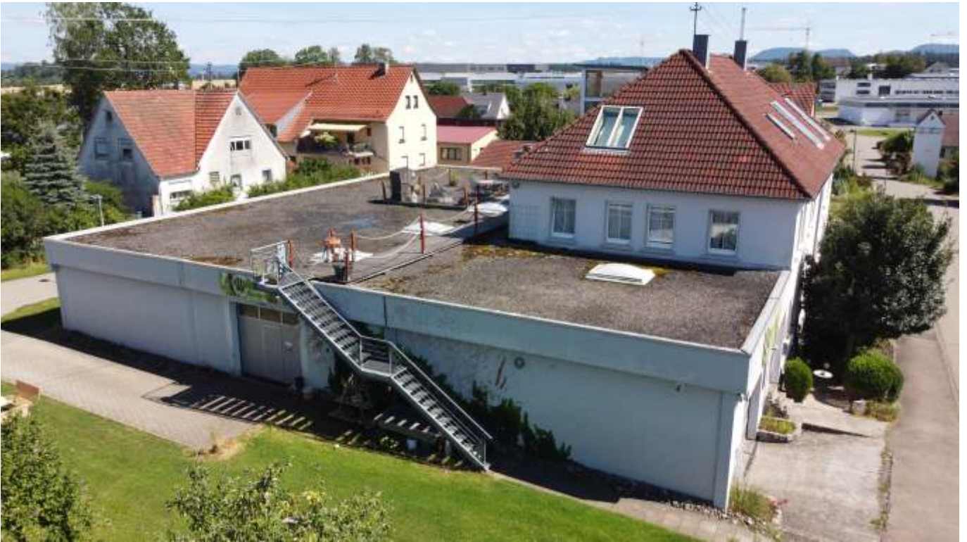
Ansicht Halle Baujahr 1975, zweite Zufahrt, Zugang Dachgeschoss Hauptgebäude
