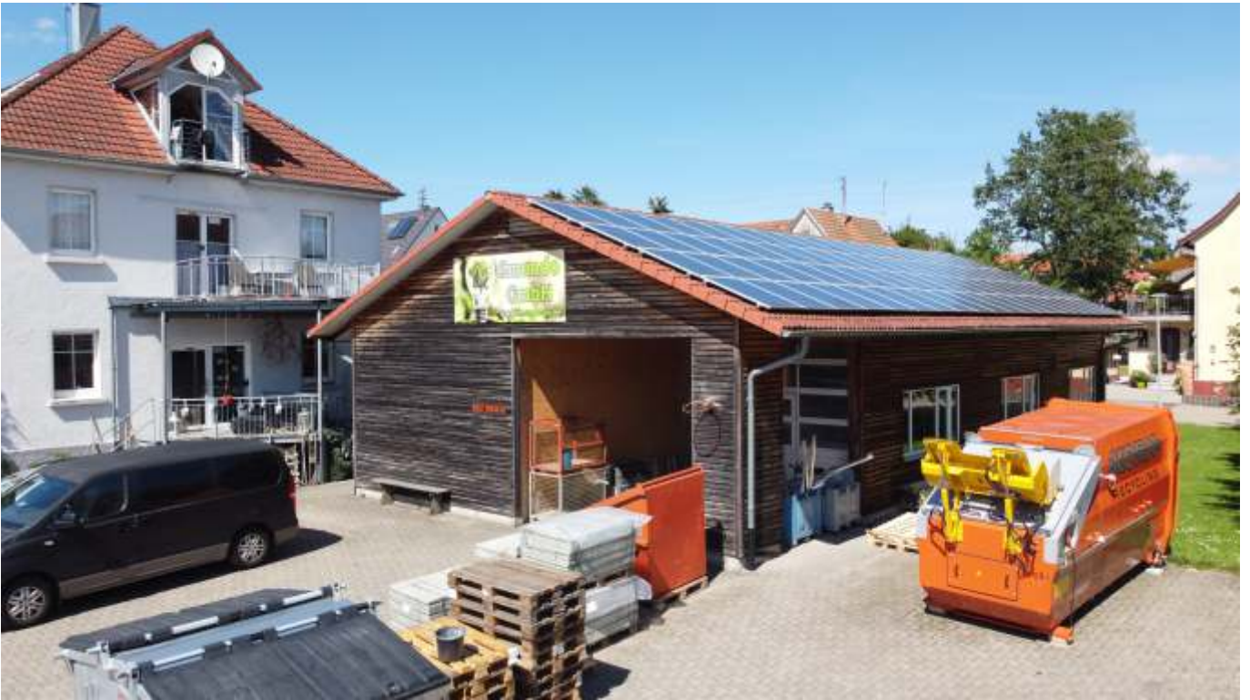
Ansicht Halle Baujahr 2000
