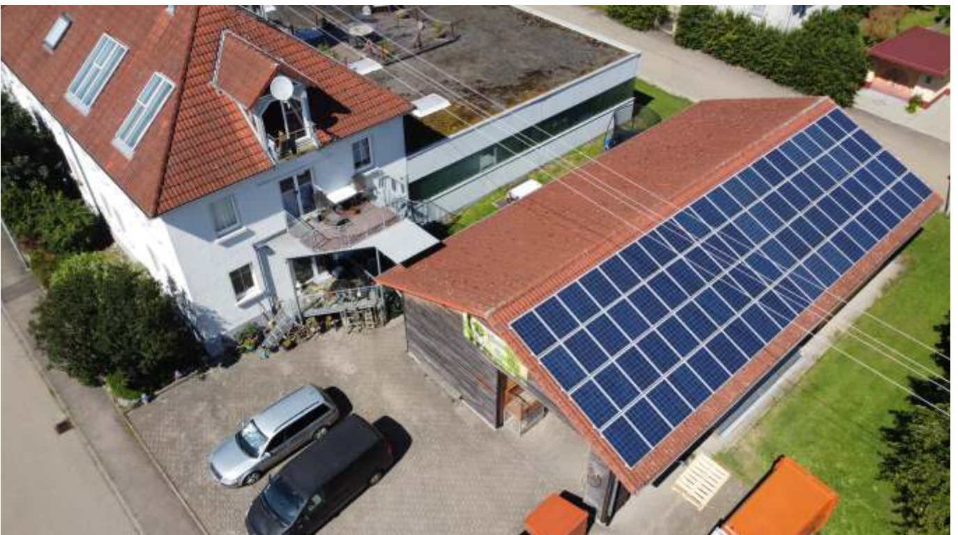
Ansicht Halle Baujahr 2000, PV-Anlage
