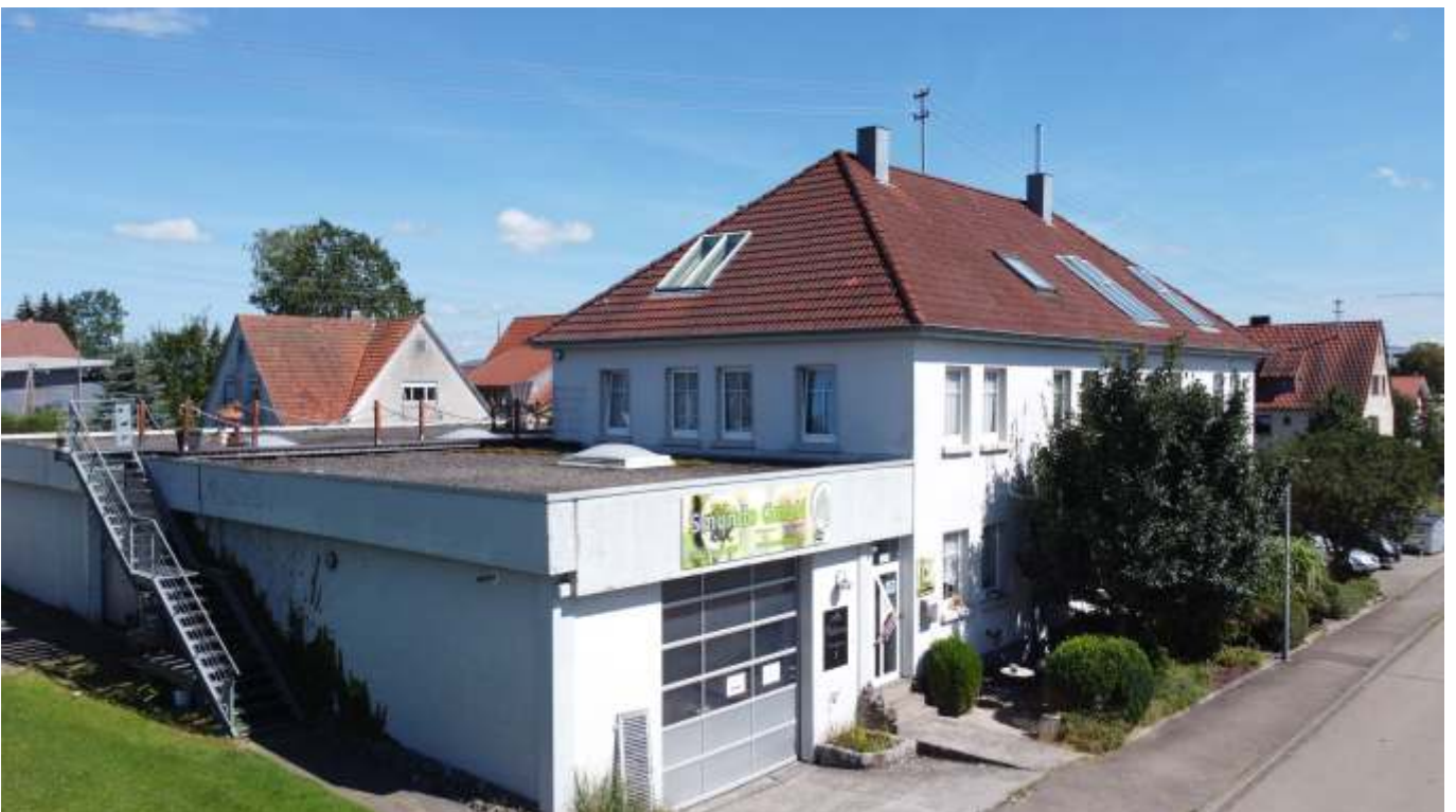
Ansicht Halle Baujahr 1975, Zufahrt Ladebereich
