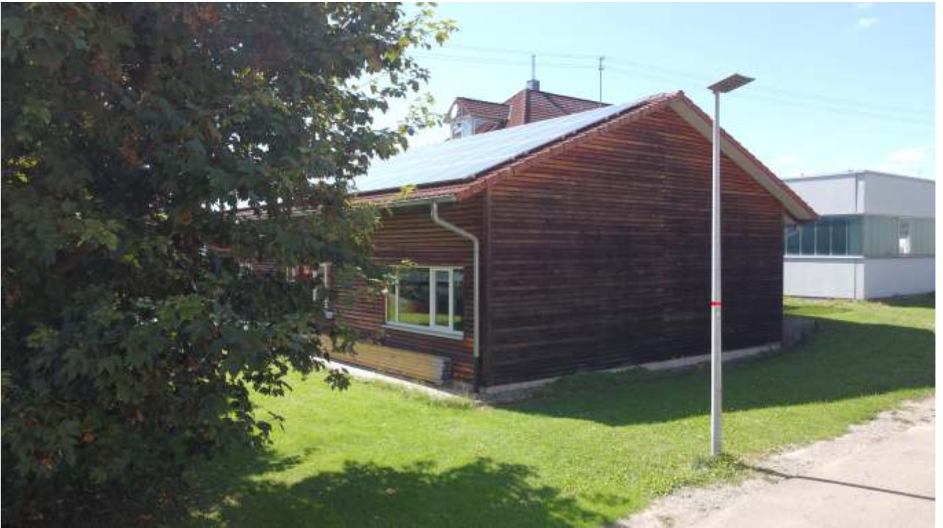
Ansicht Halle Baujahr 2000
