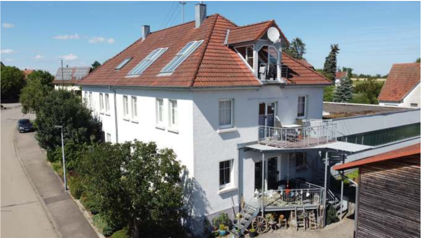
Ansicht Bestandsgebäude Baujahr 1925
